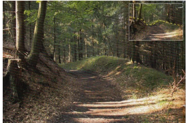
Abbildungen 11a und 11b: Spuren der Hauptstrecke auf dem heutigen Gleisweg. Links als Damm geführt zwischen Hannoverscher Heerstraße und Steinbruch und rechts als Hohlweg zwischen Bremsbergkopf und Frauenweg.
