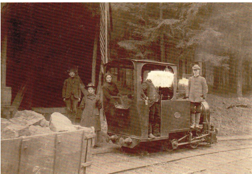
Abbildung 12: Ein nicht ganz alltägliches Bild: Die beiden Damen waren sicher zu Besuch und Anlass für das Bild. Die HANOMAG-Lokomotive 1 wartet am oberen Ende des Bremsberges am Kalkwerk. Im Vordergrund ist ein mit Kalkgestein beladener Wagen erkennbar, der am Stahlseil hängt, das zur Bremsstrommel führt. Der Wagen wartet darauf, zum Kalkwerk gebremst zu werden. Im Hin-
