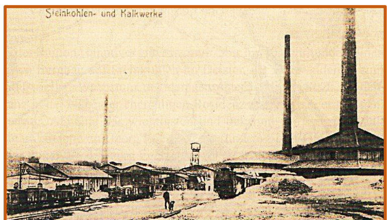
Abbildung 4: Auf diesem Ausschnitt aus einer Bredenbecker Ansichtskarte rangiert die Lokomotive am unteren Verladegleis des zweiten Ringofens mit Klappdeckelwagen mit teilweise geöffneten Klappdeckeln. Auch am Verladegleis des dreiblättrigen Ringofens stehen geöffnete Klappdeckelwagen (Mitte). Für den Kohletransport stehen offene Güterwagen auf den Zechengleisen (links).
