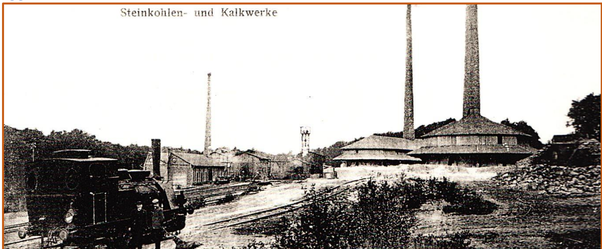
Abbildung 3: Ausschnitt aus einer Bredenbecker Postkarte: Deutlich zu erkennen ist das Fördergerüst des Schachtes Karl (Mitte hinten) und der in Form eines dreiblättrigen Kleeblatts angelegte Ringofen (rechts, hinterer Schornstein) sowie der zweite Ringofen rechts davor. An der Stelle des zweiten Ringofens standen vorher Schachtöfen, von denen auf diesem Bild nur noch Schuttberge vorhanden sind (vorne rechts). Im Vordergrund die normalspurige Tenderlok BREDENBECK auf dem Gleis, das zum zweiten Ringofen führte.
